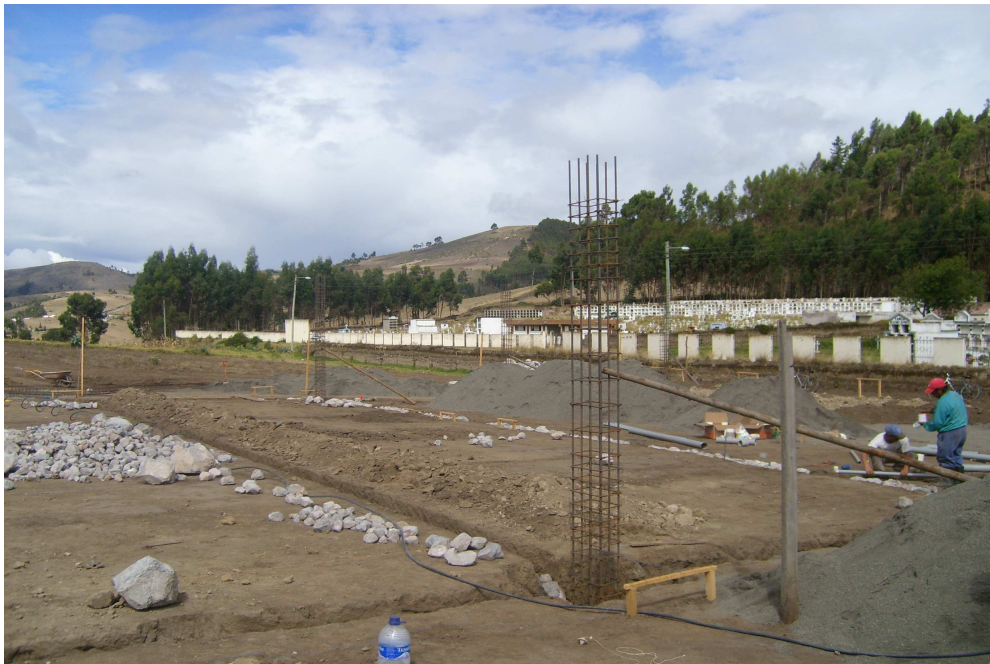
Obras del futuro centro agrotecnológico y comercial. Proyecto “Cajas de Ahorro y Crédito y fortalecimiento para la gestión comunitaria en las comunidades campesinas de Columbe y Gatazo (2º fase)”, en Ecuador
