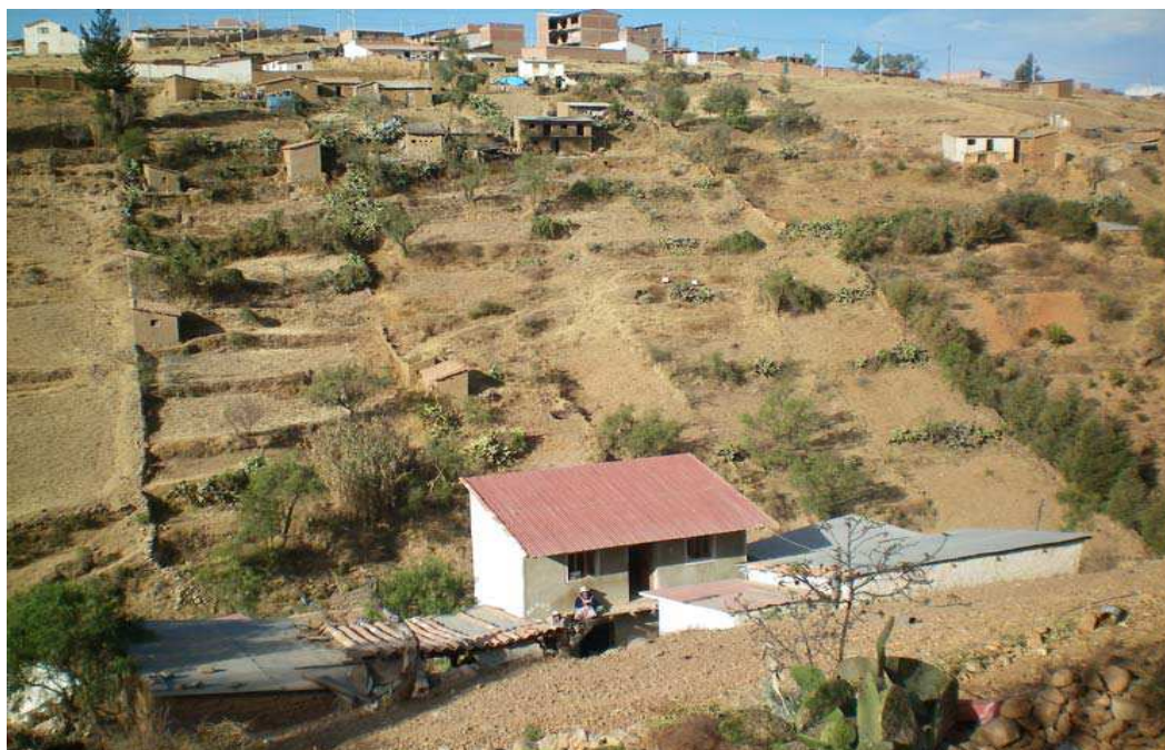
El barrio de Israel se asienta sobre suelo no urbano y cuenta con pendientes muy acusadas. Proyecto “Mejora de la salubridad en 75 viviendas del barrio de Alto San Pedro”, en Bolivia
