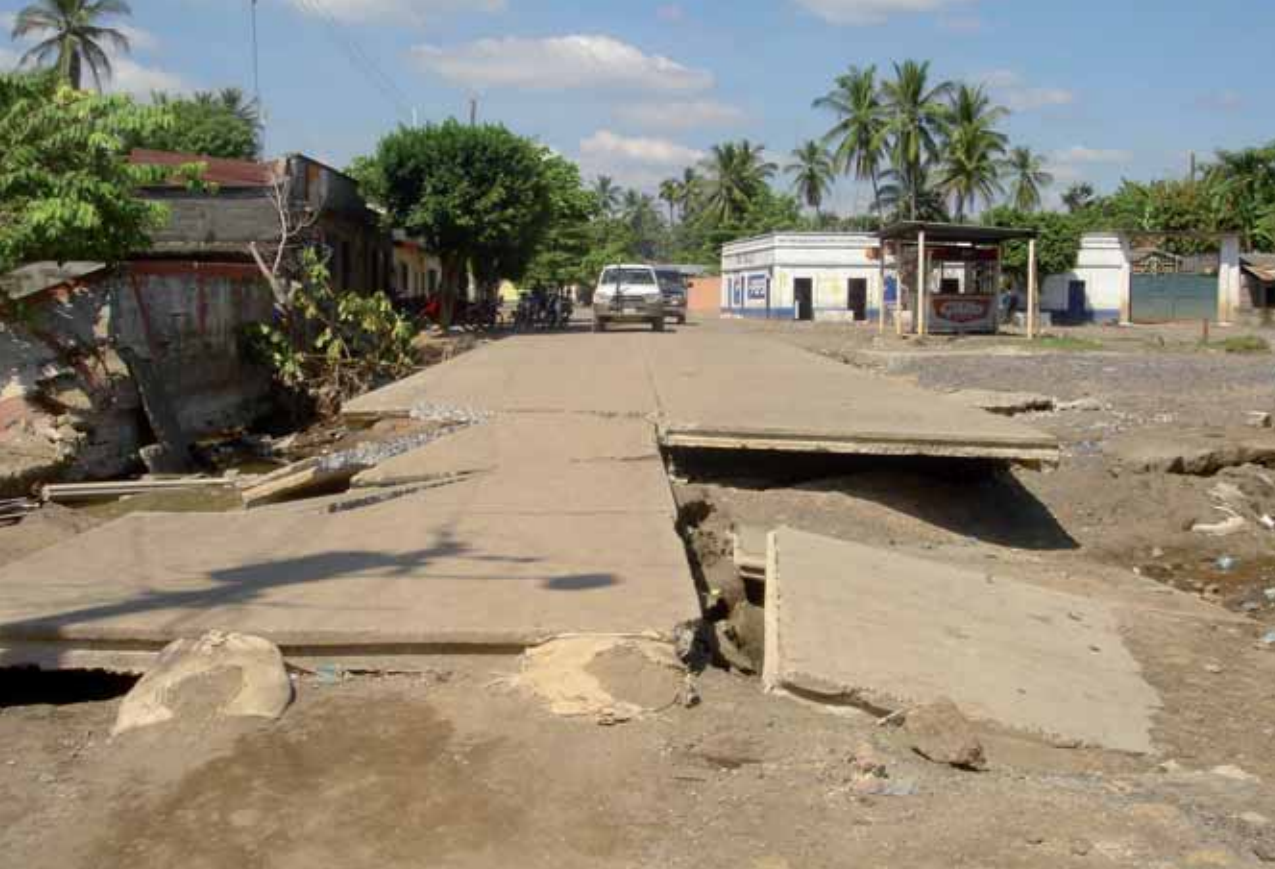
Infraestructuras y edificios destruidos durante la época de huracanes en América Central. Fuente: USAID
