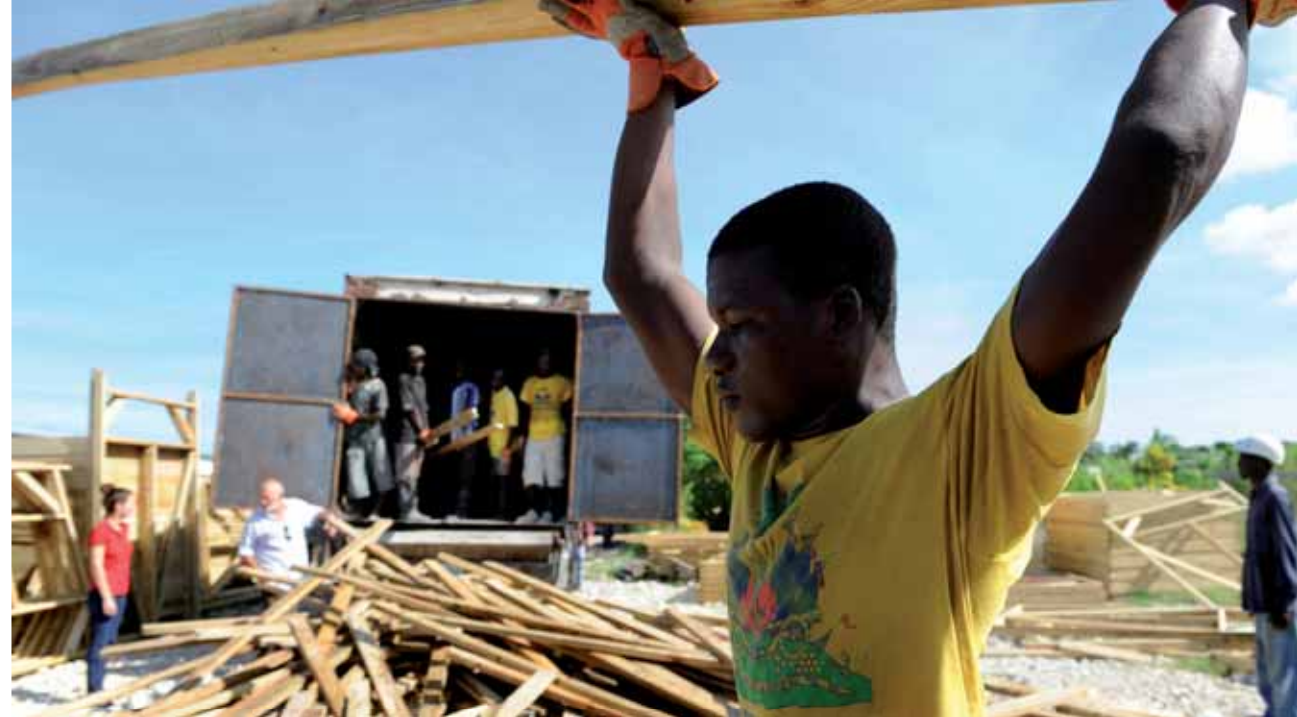
Preparación de materiales para la construcción de un albergue temporal. Fuente: Kendra Helmer/ USAID
